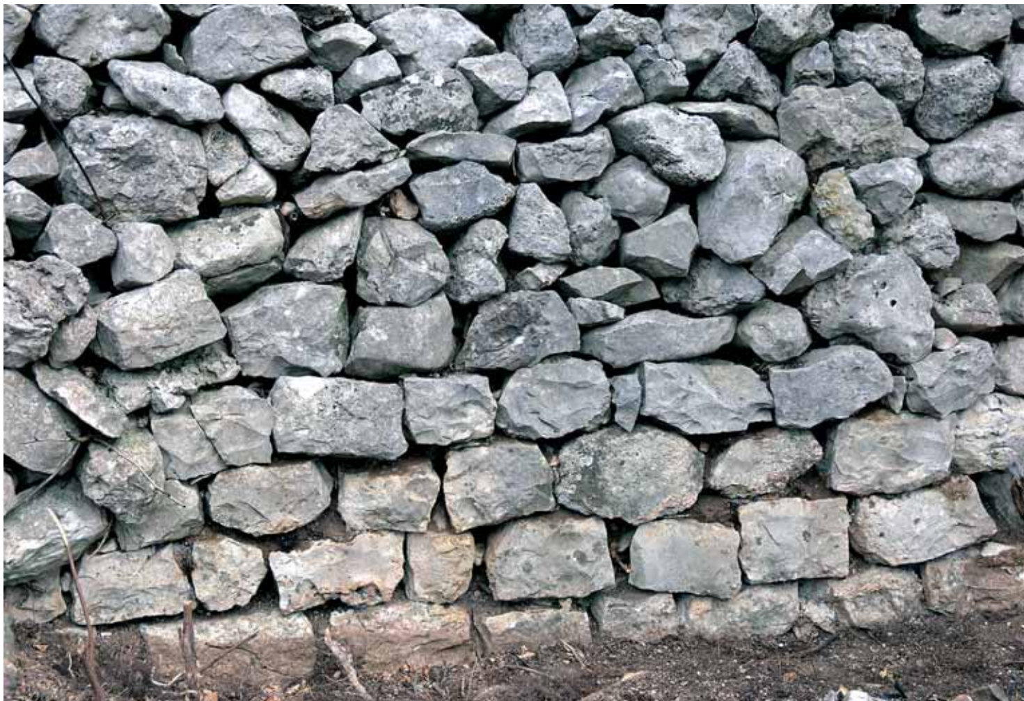
Sl. 20. Pretpostavljeni zapadni kastel, vanjsko lice istočnog bedema prekriveno suhozidnom konstrukcijom.
